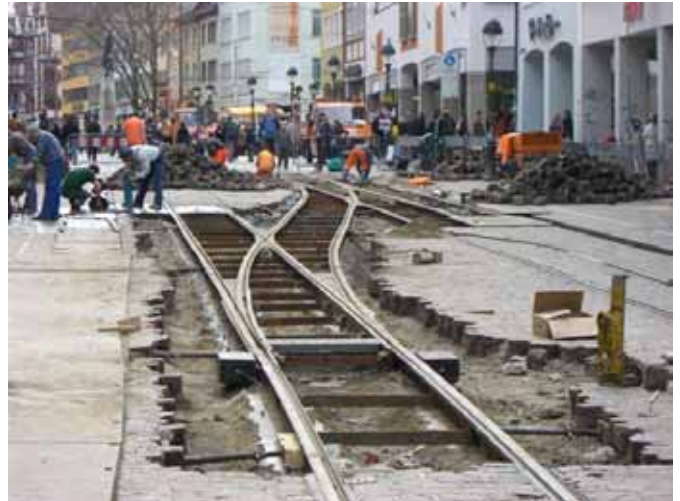
12.04.2008 · Kaiser-Joseph- Straße, in Blickrichtung Bertoldsbrunnen: Der neue Gleiswechsel ist bereits eingebaut.
