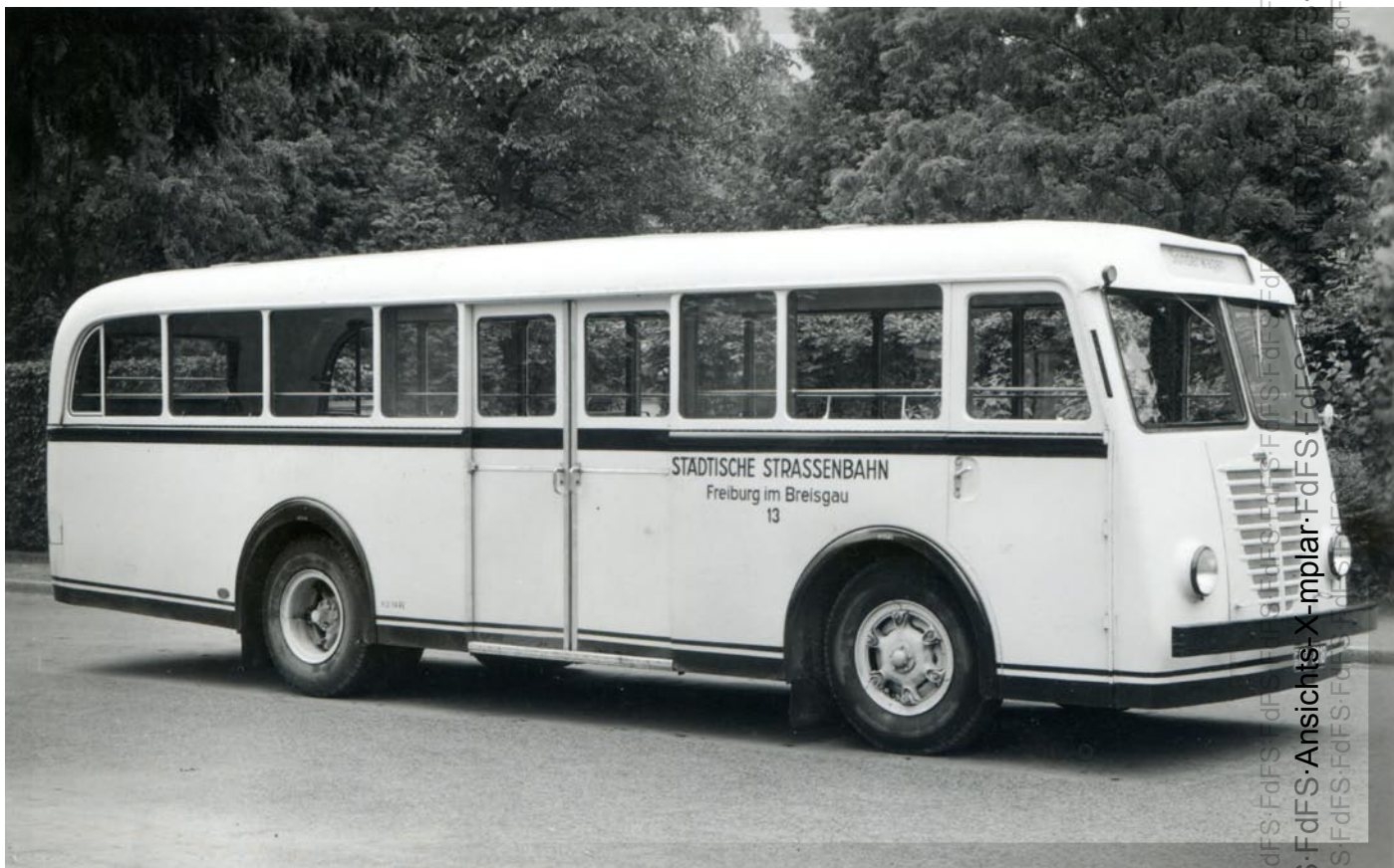
1949 · O 13 im Auslieferungszustand: Fahrgestell Büssing 5000 T/ Aufbau Vögtle & Zeller Photographie E. Baumgartner & Sohn/ Archiv H. Zeller
